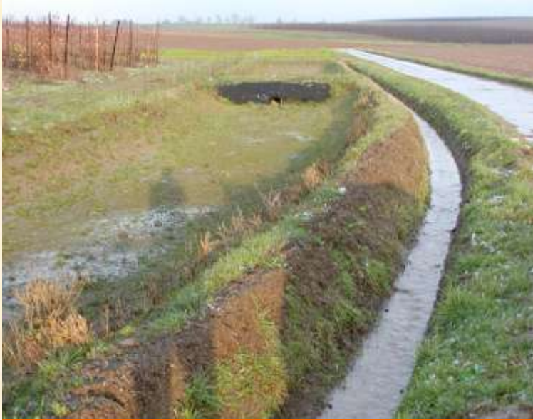
Buffersysteem onderaan laagstam plantage te Aalst
