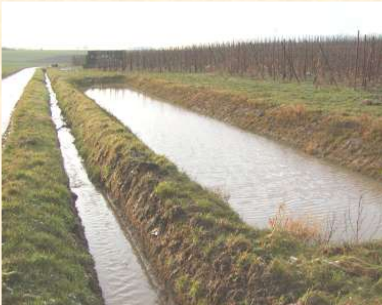
Buffersysteem onderaan laagstam plantage te Aalst
