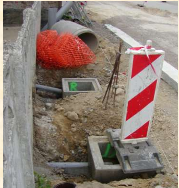
Gescheiden afvoersysteem op privé-grond
