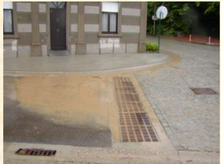
Opvangroosters voor afstromend hemelwater
